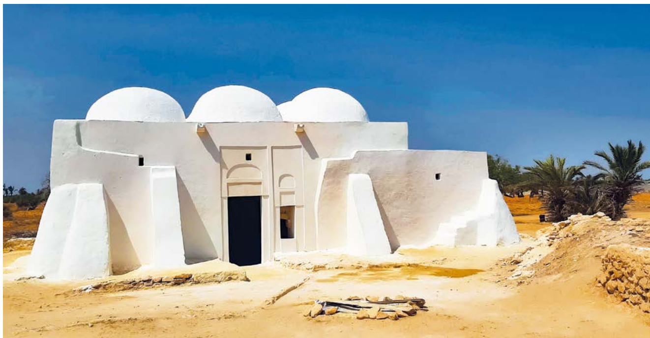
La mosquée après les travaux de réfection.
